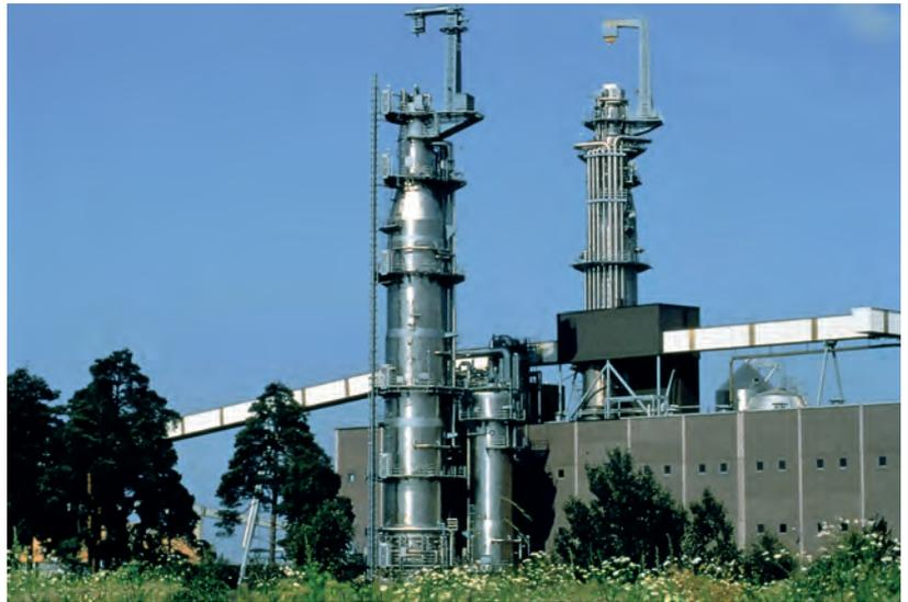
Torre de impregnación y digestión continua de pulpa de sulfato, en EN 1.4462 (2205), Sodra Cell Mönsteras, Suecia (Fuente: Kvaerner Pulping)
