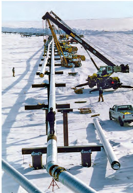
**Instalación de tubo de EN 1.4462 (2205) de 24 pulgadas aislado sobre elementos de soporte verticales en Prudhoe Bay (Fuente: Arco Exploration and Production Technology)**
